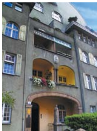
■ Kamienica zbudowana w 1912 r. w stylu modernistycznym z alegoryczną figurą kobietą na postumencie (w podcieniu), dekoracyjne portale i loggie, historyczne: stolarka drzwiowa, okienna z malowanymi okiennicami, witraże i ceramika w bramie. Tutaj mieszkał przez ponad 14 lat muzykolog prof. Adolf Dygacz.
