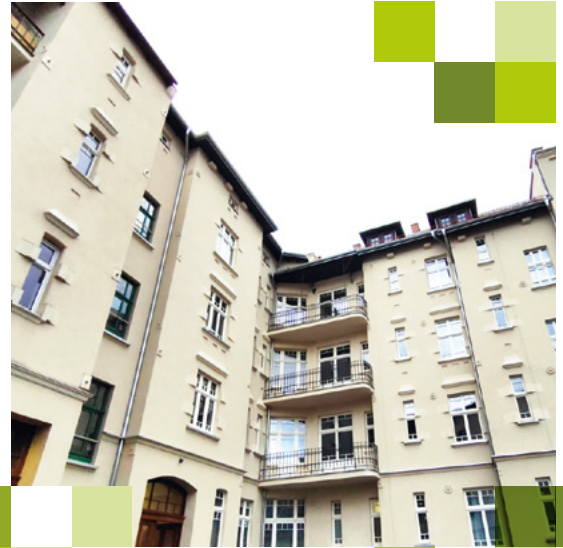
Budynki mieszkalne przy ul. Gliwickiej 13, fot. KZGM
