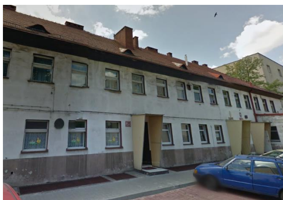
Rysunek 43 Budynek przy ul. Ciesielskiej 1 - wejście
