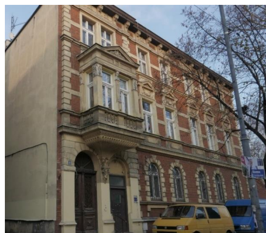
Rysunek 48 Budynek przy ul. Bednorza 14
