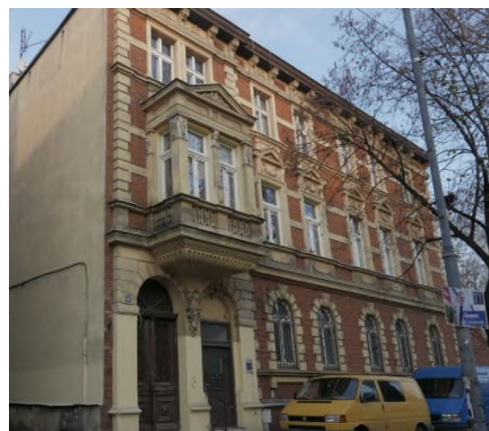
Rysunek 62 Budynek przy ul. Bednorza 14
