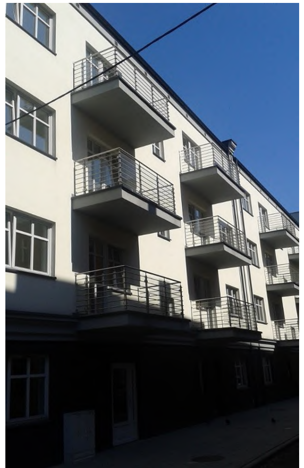
Rysunek 29 ul. Kordeckiego 3b, 4b - nowe budynki
