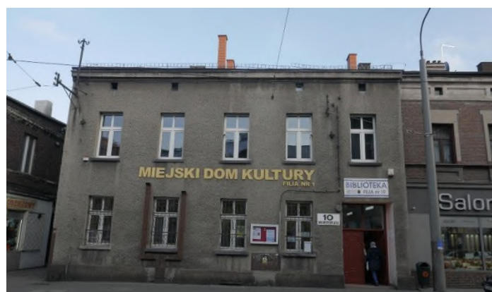
Rysunek 59 Budynek przy ul. Obrońców Westerplatte 10 – stan przed
