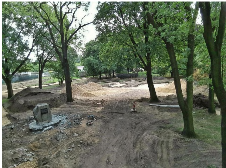
Rysunek 38 Plac Londzina – prace budowlane (2) (źródło: Pracownia AMAYA ARCHITEKCI)
