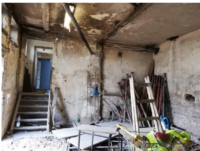
Rysunek 48 Pomieszczenie kotłowni - przed remontem (1)
