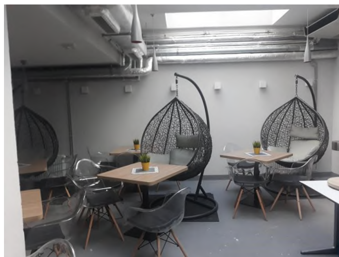
Rysunek 51 Pomieszczenie kotłowni – po remoncie (2)
