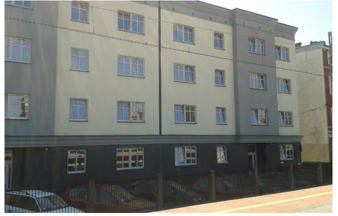
Rysunek 26 ul. Kordeckiego 3b, 4b - nowe budynki
