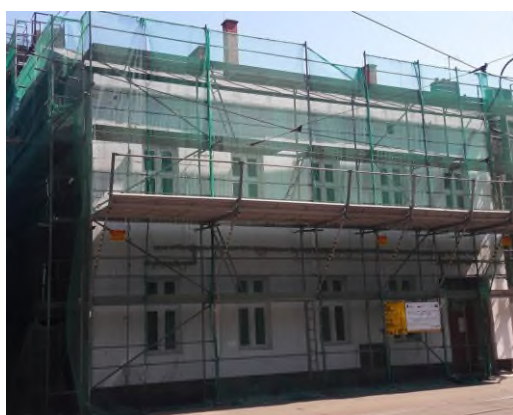
Rysunek 58 Prace termomodernizacyjne budynku
