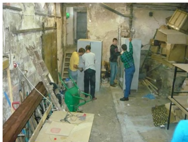
Rysunek 49 Pomieszczenie kotłowni - przed remontem (2)
