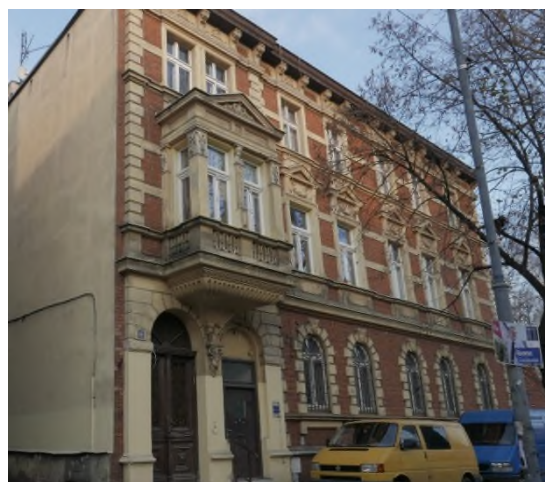
Rysunek 114 Budynek przy ul. Bednorza 14
