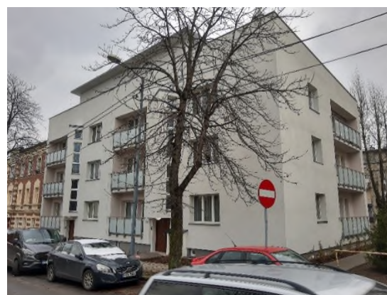
Rysunek 116 Olchawy 3-5 – budynek po modernizacji
