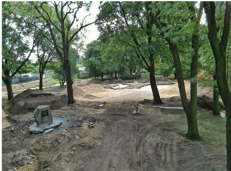
Rysunek 68 Plac Londzina – prace budowlane (2) (źródło: Pracownia AMAYA ARCHITEKCI)
