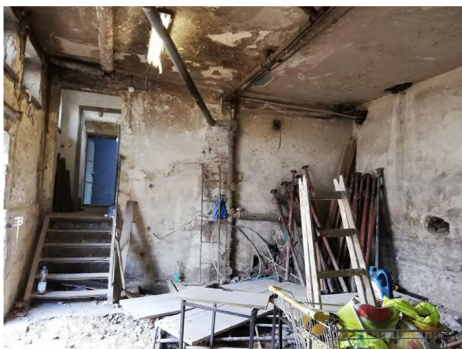
Rysunek 96 Pomieszczenie kotłowni - przed remontem (1)
