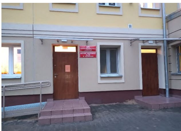
Rysunek 108 Ciesielska 1 - budynek po termomodernizacji (1)
