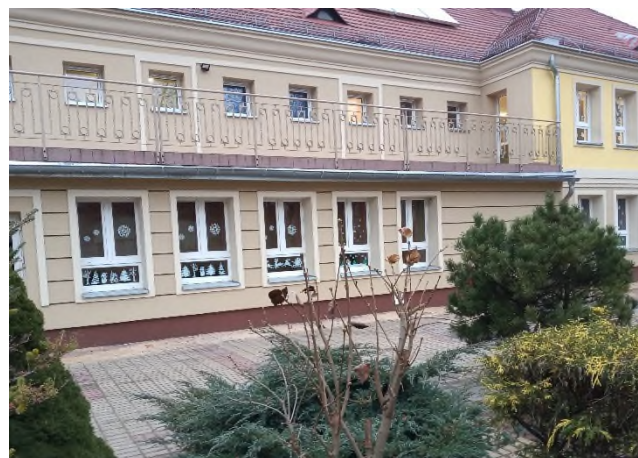
Rysunek 109 Ciesielska 1 - budynek po termomodernizacji (2)
