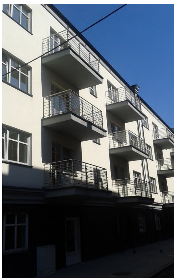
Rysunek 52 ul. Kordeckiego 3b, 4b - nowe budynki
