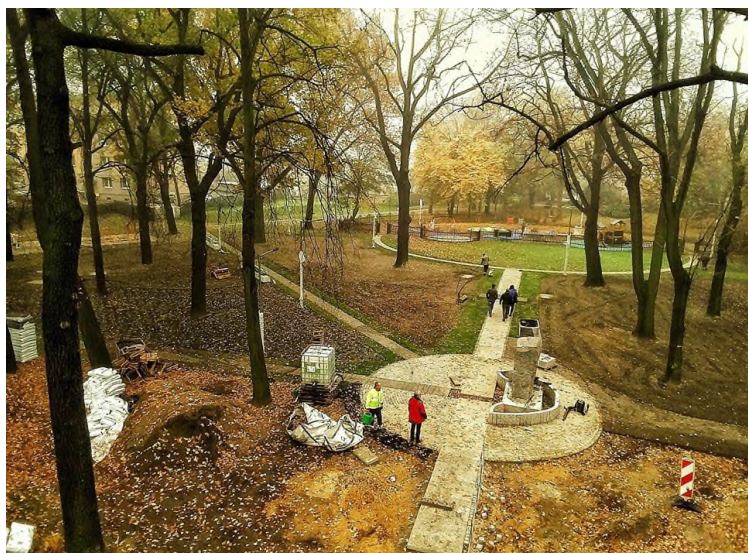
Rysunek 67 Plac Londzina – prace budowlane (1) (źródło: Pracownia AMAYA ARCHITEKCI)
