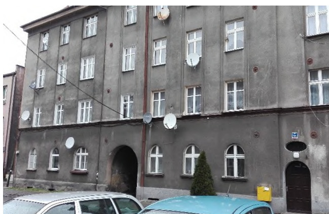
Rysunek 32 Zarębskiego 5a – budynek przed modernizacją
