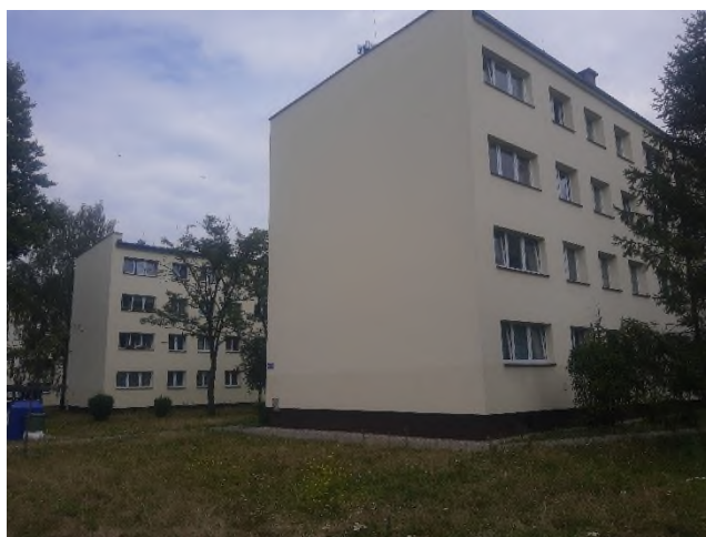
Rysunek 80 Zamenhofa - po modernizacji
