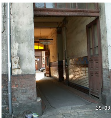
Rysunek 34 Gliwicka 13 – przed modernizacją (1)
