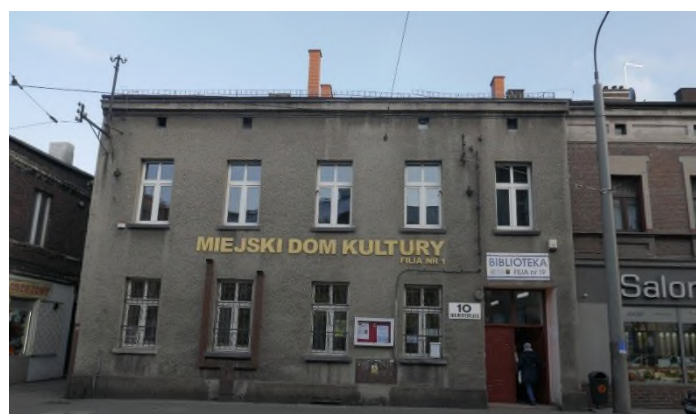
Rysunek 111 Budynek przy ul. Obrońców Westerplatte 10 – przed termomodernizacją
