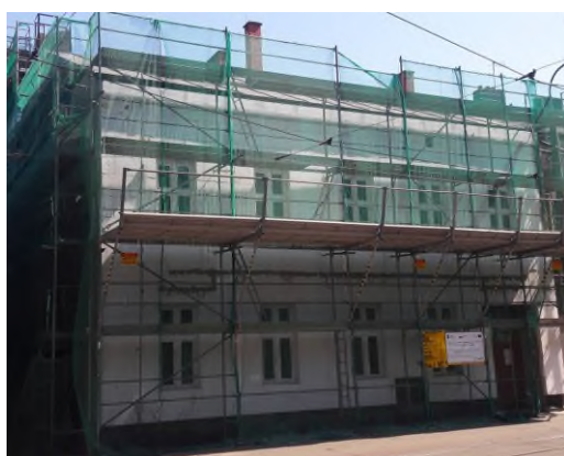
Rysunek 110 Prace termomodernizacyjne budynku
