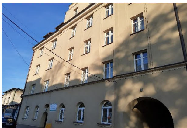
Rysunek 33 Zarębskiego 5a – budynek po modernizacji
