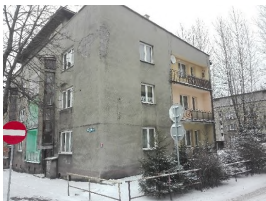
Rysunek 115 Olchawy 3-5 – budynek przed modernizacją
