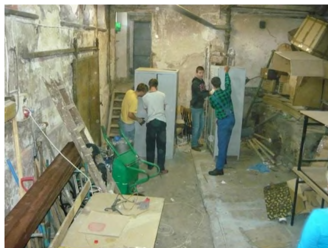
Rysunek 97 Pomieszczenie kotłowni - przed remontem (2)
