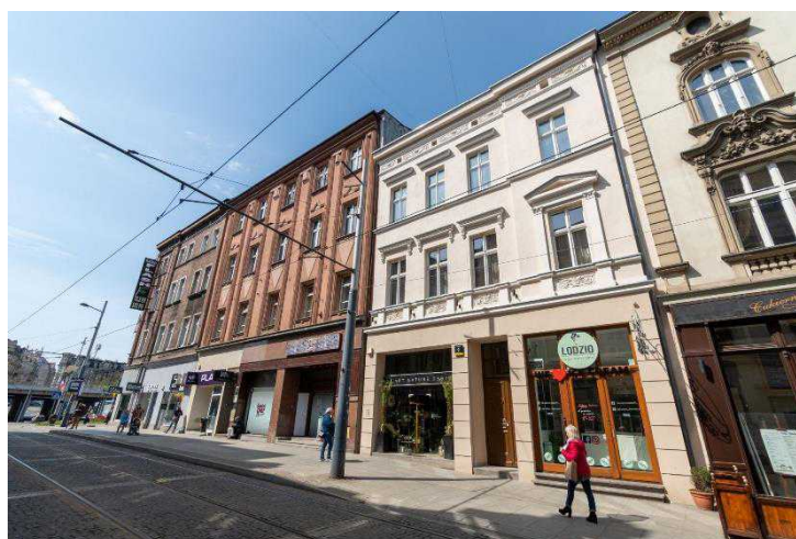
Budynek przy ul. Św. Jana 9 – stan po
