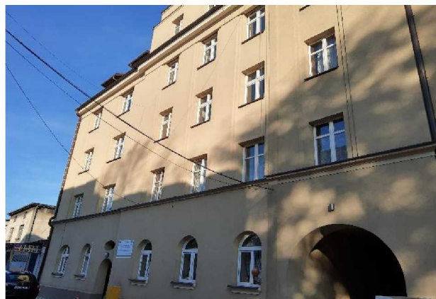
Zarębskiego 5a – budynek po modernizacji
