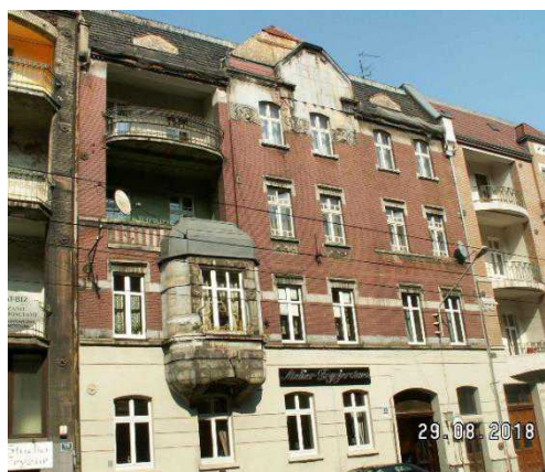
Gliwicka 13 – przed modernizacją (2)
