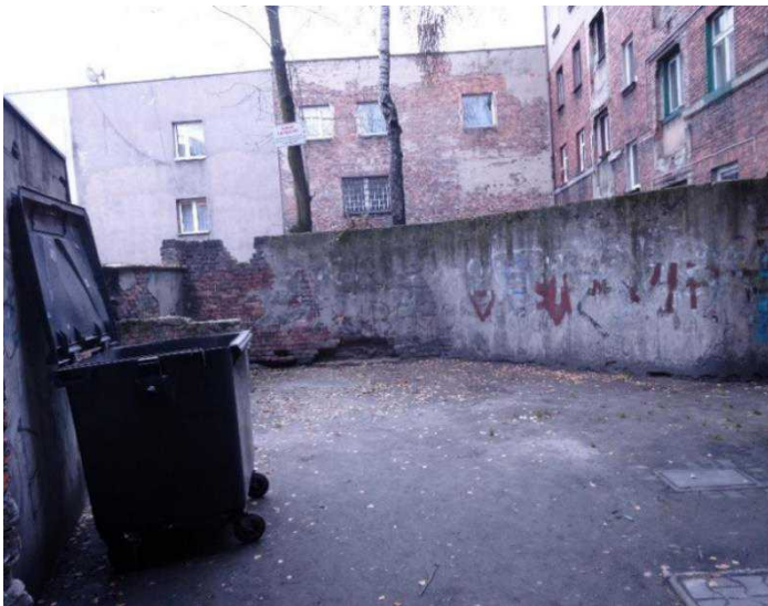
Karola 3 – przed modernizacją (1)
