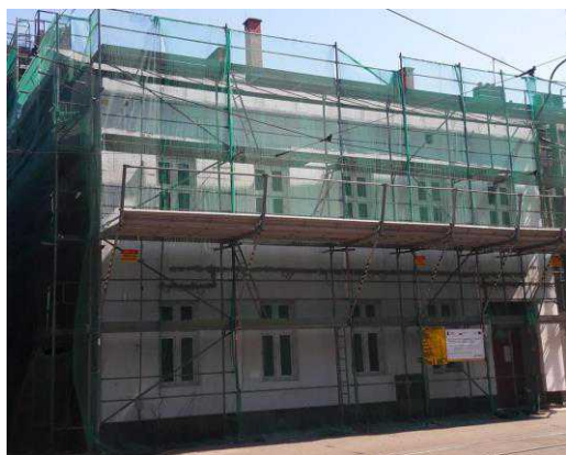
Prace termomodernizacyjne budynku
