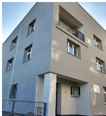
Zarębskiego 7a – po modernizacji
