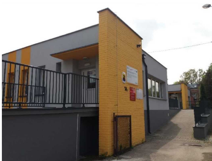
Gliwicka 74A – budynek po modernizacji (1)
