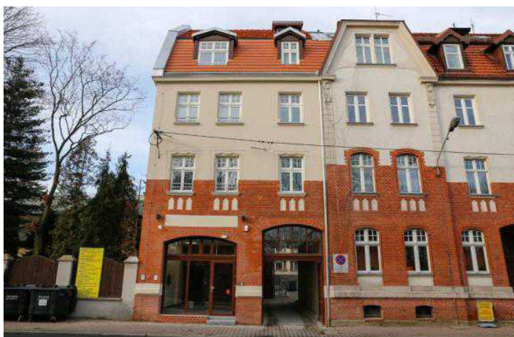
Budynek przy ul. Francuskiej 43
