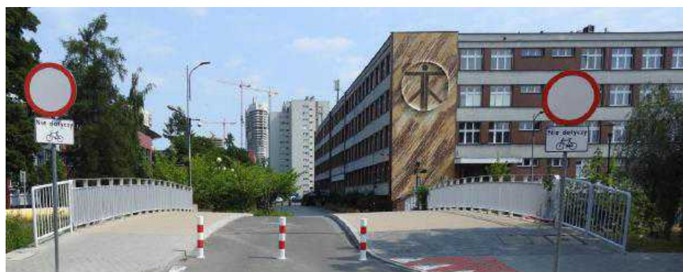
Kładka oraz most nad rzeką Rawą – po
