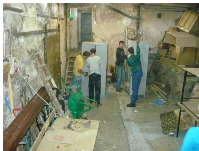
Pomieszczenie kotłowni - przed remontem (2)
