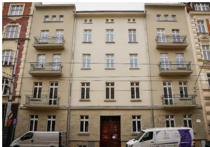
Budynek przy ul. Gliwickiej 4 – stan po
