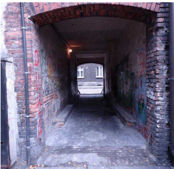
Karola 3 – przed modernizacją (2)
