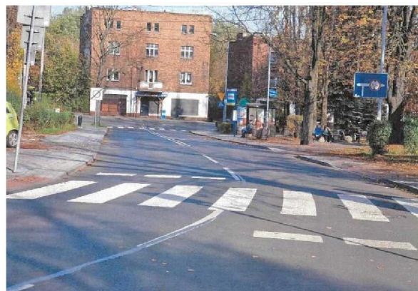
Ul. Zamkowa – po remoncie
