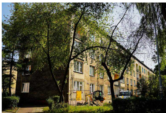
Wiosny Ludów 23-37 – budynek przed modernizacją
