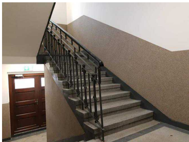
Wolnego 8 – klatka schodowa po modernizacji
