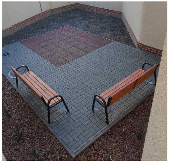
Karola 3 – po modernizacji (1)
