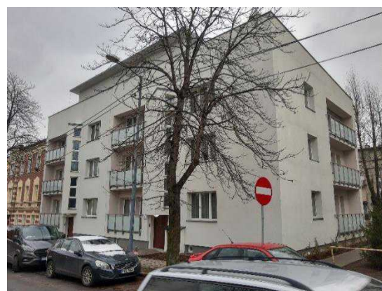
Olchawy 3-5 – budynek po modernizacji
