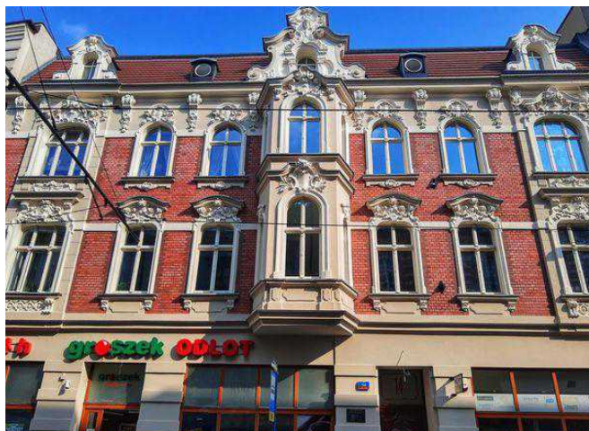
Budynek przy ul. Św. Jana 14 – stan po
