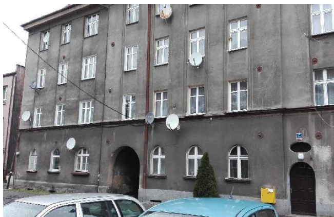
Zarębskiego 5a – budynek przed modernizacją
