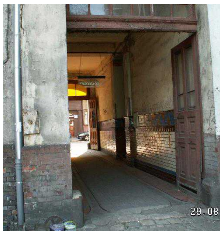
Gliwicka 13 – przed modernizacją (1)
