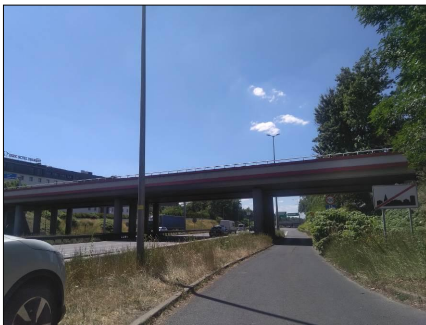
FOTOGRAFIA 4. AUTOSTRADA A4 ( ALEJA GÓRNOŚLĄSKA) I WIADUKT UL. WITA STWOSZA – WIDOK ZE ZJAZDU OD UL. WITA STWOSZA
